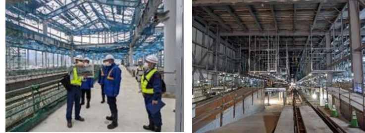
(左：新幹線ホーム、右：敦賀車両基地)
